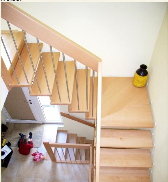
Steiggeländer als Relinggeländer aus **mitlaufenden Edelstahlstäben**  $\varnothing$  ca. 8 mm, mit Klemmbeschlägen an senkrechten Edelstahlstäben befestigt, glattem Holzhandlauf ca. 160/45 mm und glatten An- und Austrittspfosten wie Handlauf.
